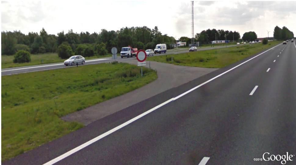
Foto 3 – Doorsteek t.b.v. hulpdiensten in de middenberm van autosnelweg A6 (zonder beweegbare fysieke afsluiting)
