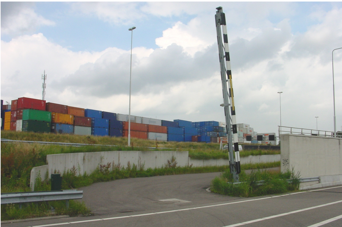
Foto1 – Calamiteitdoorsteek met beweegbare fysieke afsluiting in een geleiderailconstructie
