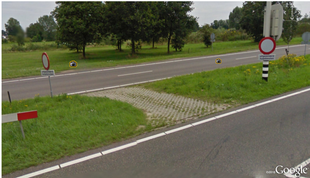
Foto 4 – Doorsteek in de tussenberm t.b.v. hulpdiensten zonder beweegbare fysieke afsluiting (aansluiting A1 – A30).
