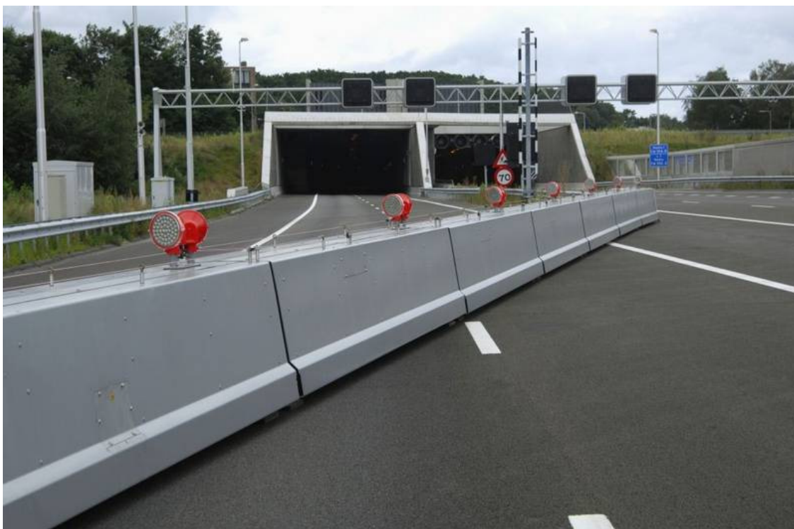
Foto 8 – Voorbeeld van een horizontale beweegbare afsluiting in middenberm
